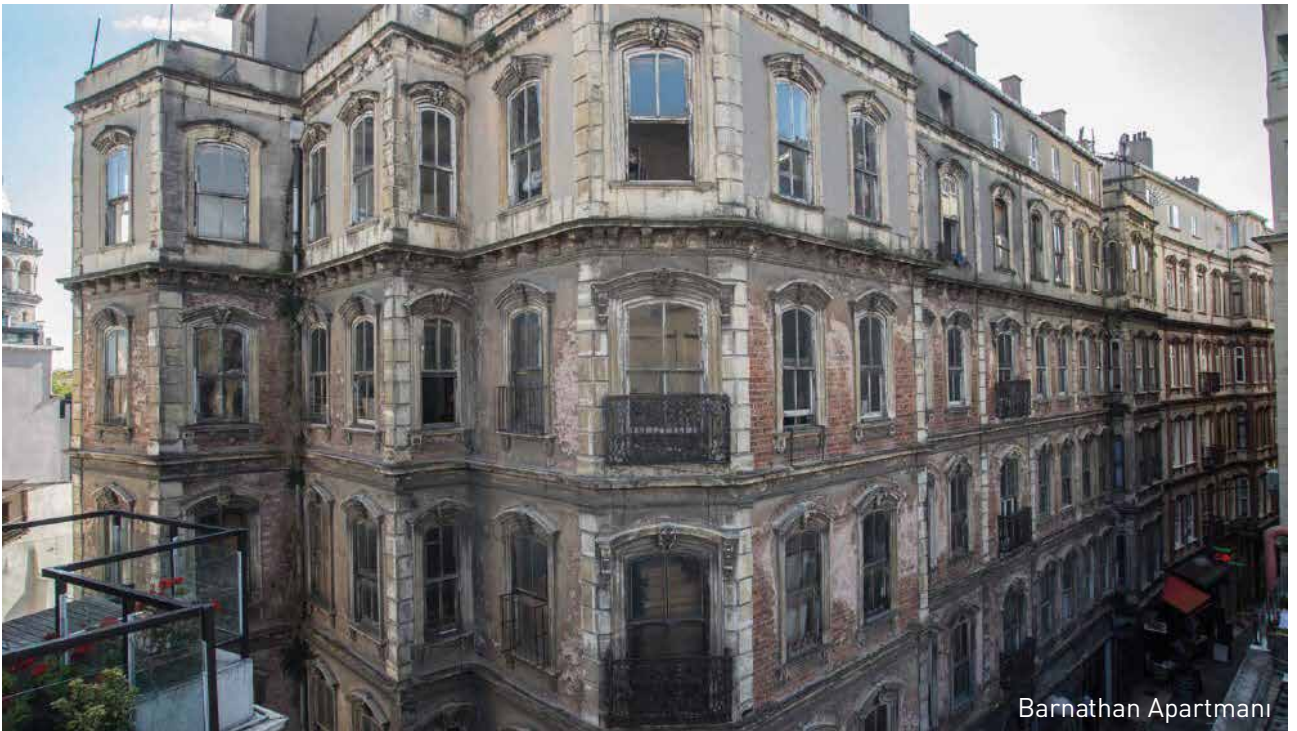
Barnathan Apartmanı restorasyon öncesi giriş kapısı
