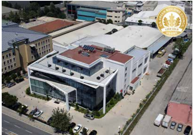
Birleşim Grup Merkez Ofis ve Fabrika Binası
